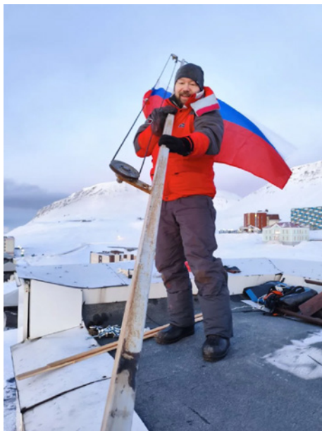
Роман Морозов устанавливает флагшток на крыше КСК.
