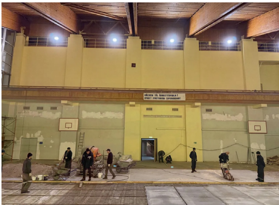
Зал «Дружба» во время ремонта.
