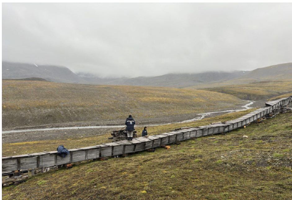
Работы по ремонту водовода на западном берегу Грэн-фьорда.
