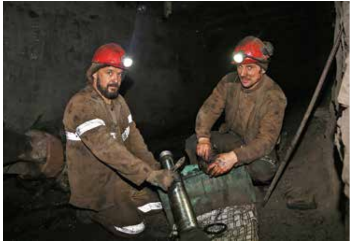
Машинист горных выемочных машин участка проходки горных выработок Александр Семенченко (слева) и бригадир проходчиков Василий Костельный и производят ремонт комбайна.
