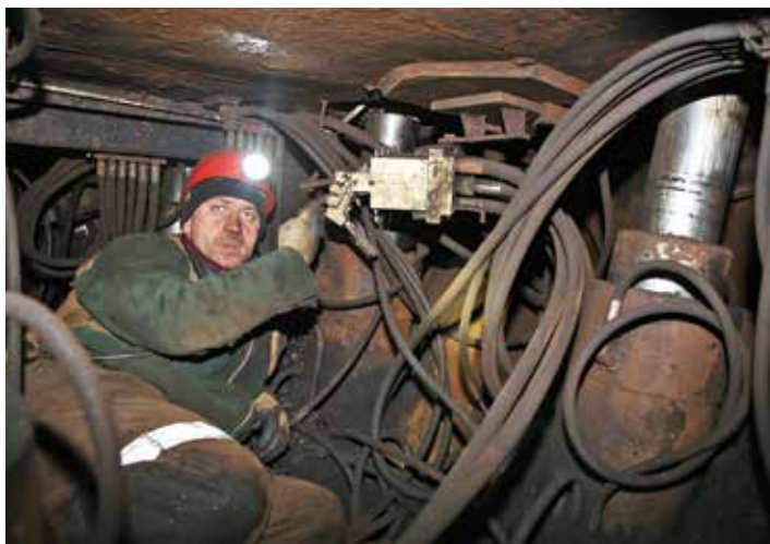
ГРОЗ Анатолий Маруцак производит ремонт и обслуживание механизированного комплекса.
