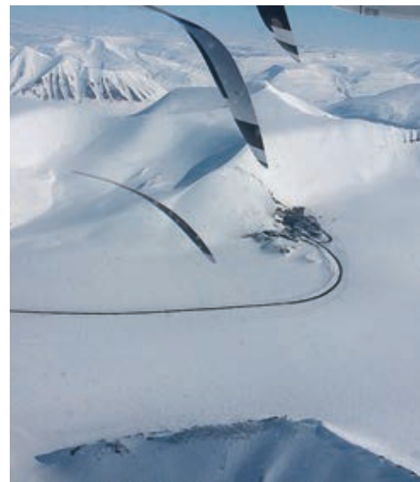
Шахта «Лункефьелль» расположена почти в 15 км от Свеи.
