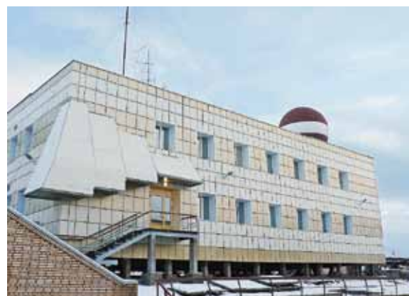
Лабораторный корпус ГМО Баренцбург после реконструкции.
