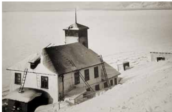
«Розовый дом» – бывшее жилое здание сотрудников обсерватории, 1965 г. ФОТОГРАФИЯ: ВАЛЕНТИНА МИХАЙЛОВА.
