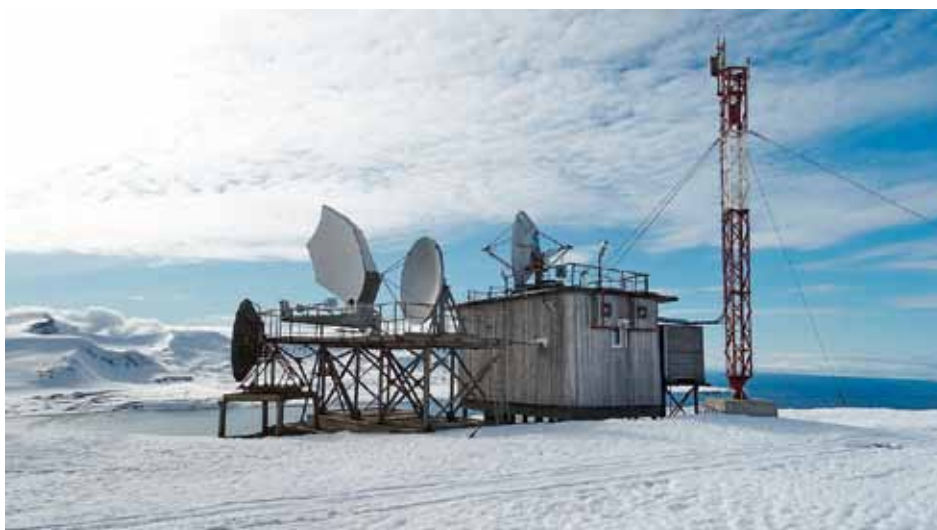
Спутниковый узел на горе Олаф. Вид снаружи и внутри. ФОТОГРАФИИ ПРЕДОСТАВЛЕНЫ IT-ОТДЕЛОМ БАРЕНЦБУРГА.
