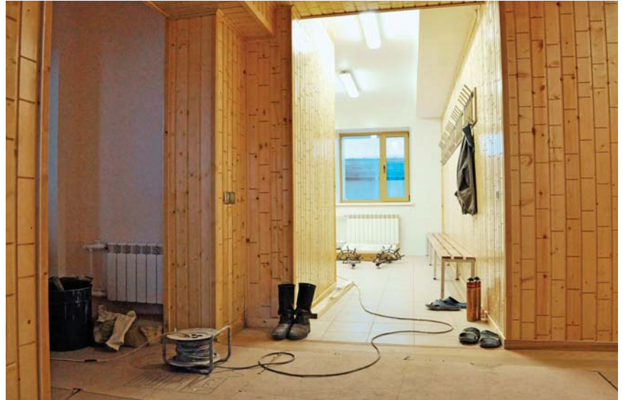
Первый этаж практически готов к сдаче – осталось навести лоск.
