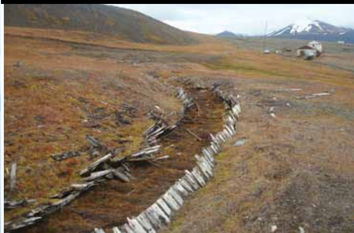
Фрагмент 900-миллиметровой колеи с остатками защитной деревянной галереи между Грумантом и Колсбеем. ВСЕ ФОТОГРАФИИ: МИХАИЛ КУЖИМ
