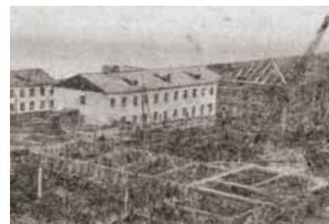
Общий вид строительства гостиницы. ФОТОГРАФИИ ИЗ АРХИВА «ПОЛЯРНОЙ КОЧЕГАРКИ». АВТОР: НИКОЛАЙ КИМИНЖЕР
