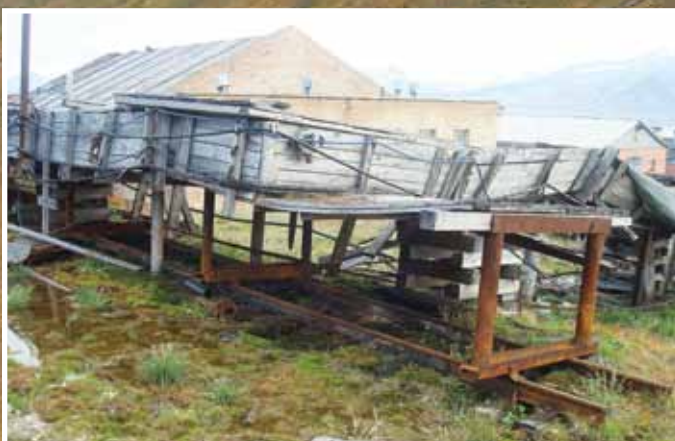
Участок узкоколейки, начинающийся у шахты №5 в Баренцбурге. На участке установлен короб с коммуникациями от поселка к подсобному хозяйству.
