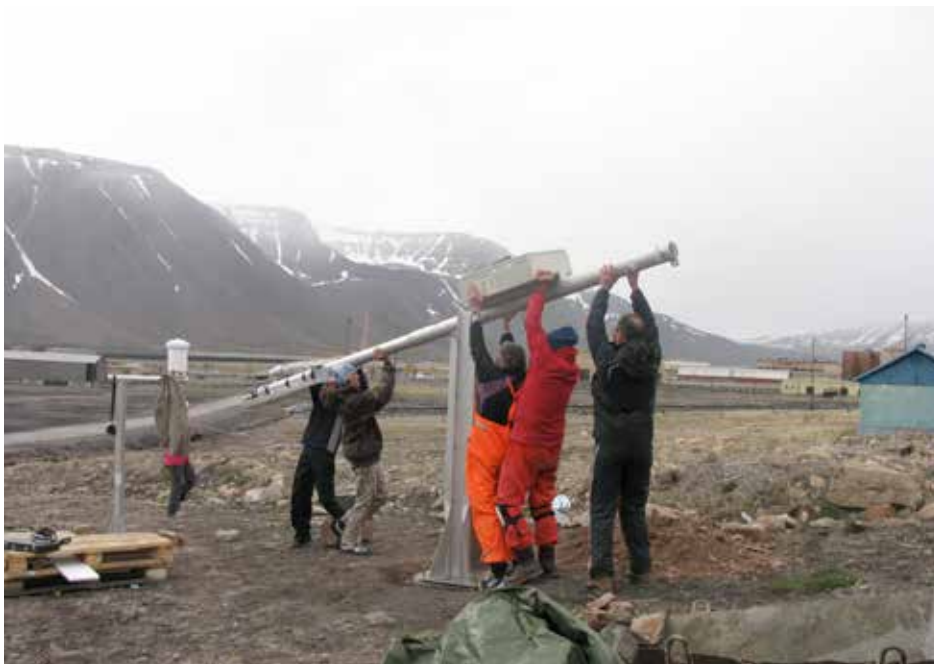
Установка автоматической метеостанции. 2011 г.
