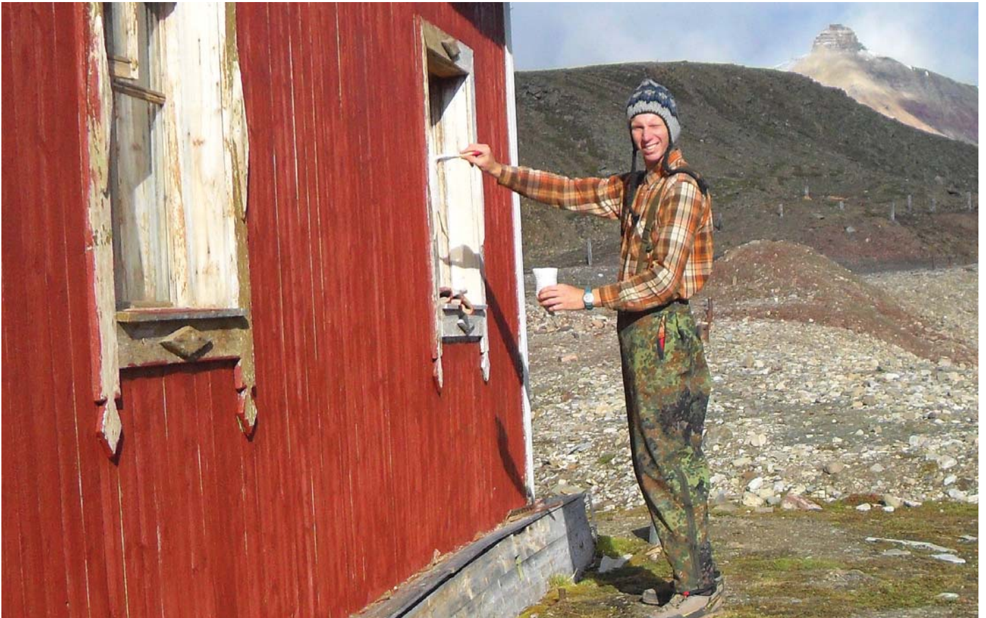
Кирилл Маслеников за ремонтом дома на Голубом озере: чтобы успеть покрасить фасад, нужно ловить переменчивую шиццбергенскую погоду. ФОТОГРАФИЯ ПРЕДОСТАВЛЕНА КИРИЛЛОМ МАСЛЕНИКОВЫМ
