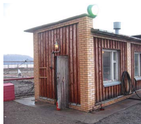
Заправочная станция в помещении бывшей операторской горюче-смазочных материалов
