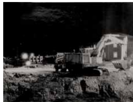
На строительстве спорткомплекса. ВСЕ ФОТОГРАФИИ: АРХИВ ТРЕСТА «АРКТИКУГОЛЬ»
