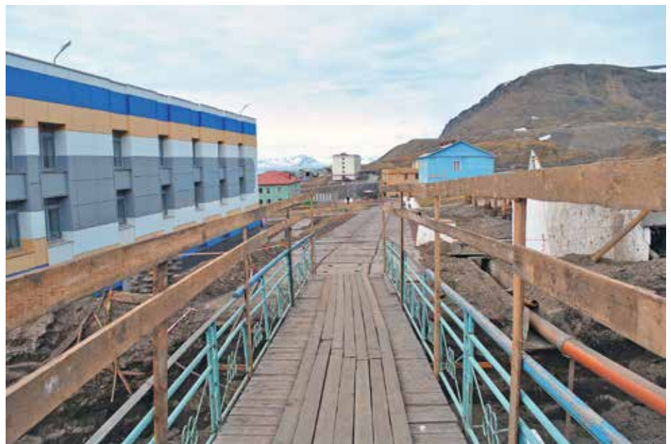
Для замены теплосетей потребовалось временно вскрыть дорожное полотно на улице Старостина. Июль 2014 г. ФОТОГРАФИЯ: НАТАЛИЯ ШМАТОВА
