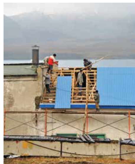
Ремонт кровли мехцеха
