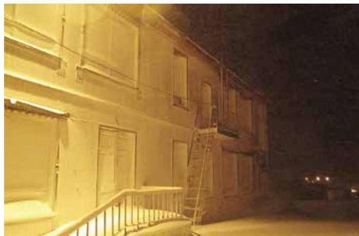
Лестницы домов почти полностью засыпаны снегом.
